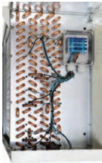
شکل ۶-۱۱- محل نصب هیترهای مورد نیاز برای برفک زدایی
