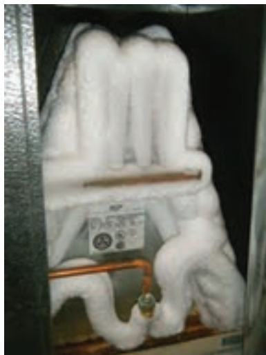
شکل ۶-۱۰- تشکیل برفک بر روی اواپراتور
